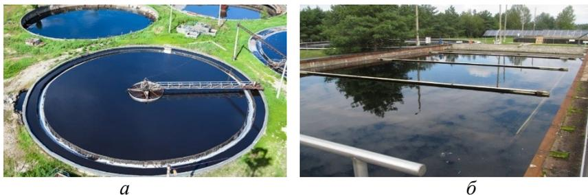
Рис. 1. Отстойники<sup>3</sup> механической очистки сточных вод: радиальный (а) и горизонтальный (б)
