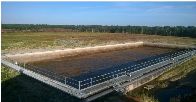
*Рис. 3. Аэротенк для биологической очистки сточных вод<sup>5</sup>*
